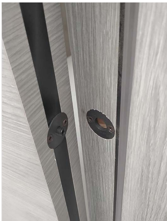
Rostro passivo su porta Rei 30 Guarnizione tumescente su anta
