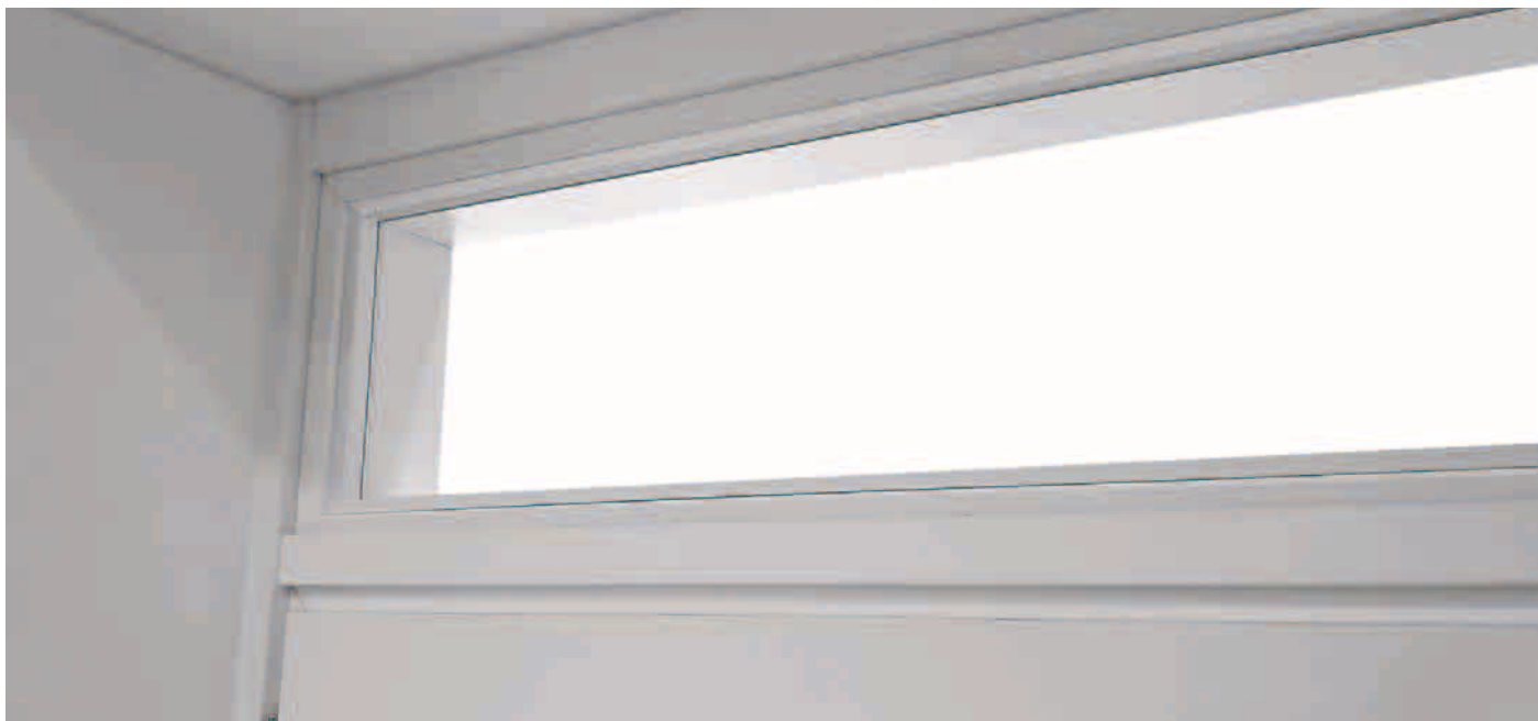
Sopraluce lato interno
